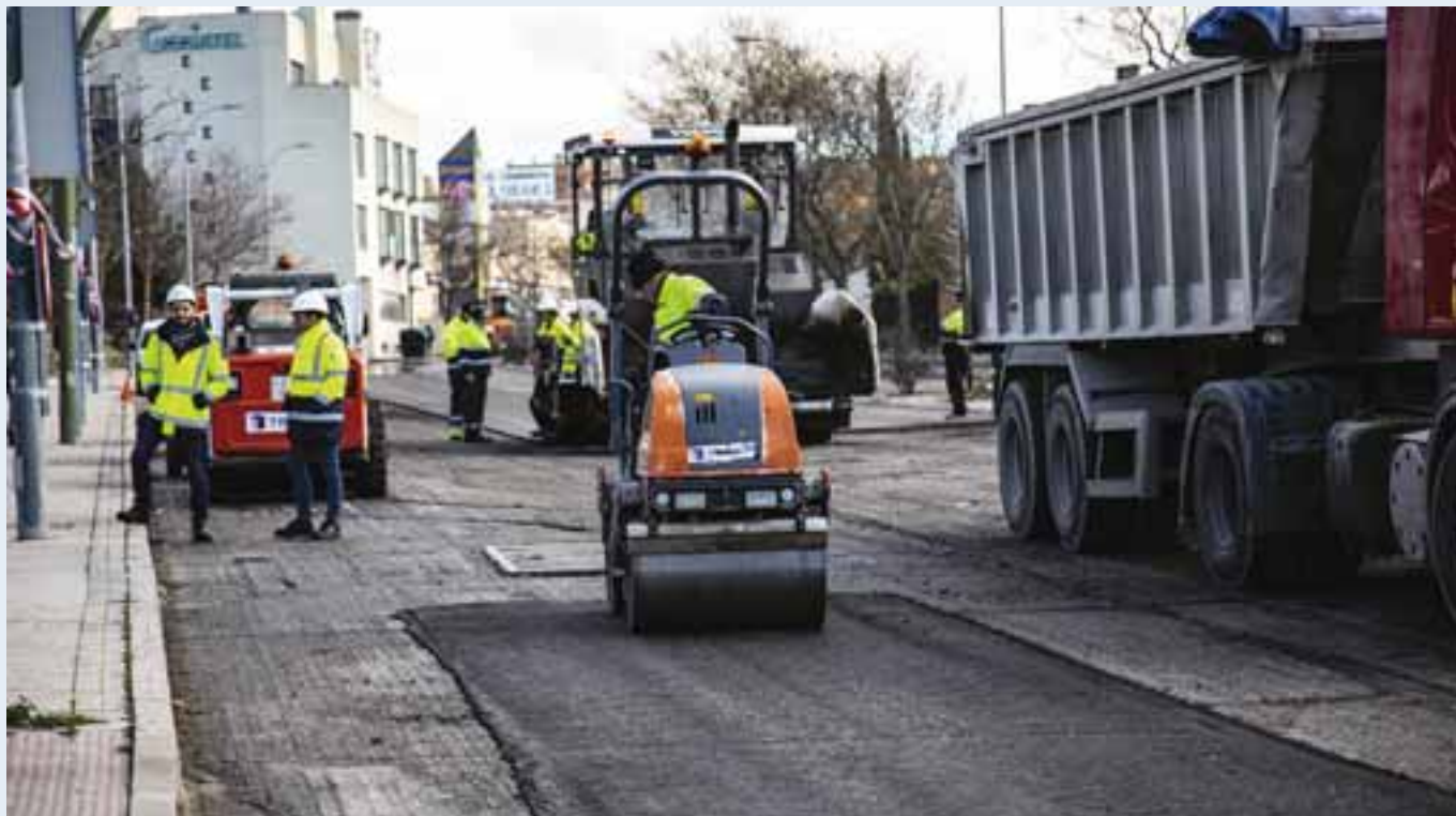
Trabajos de aplicación del asfalto ecológico en un tramo del paseo de las Provincias. P. MARISCAL
