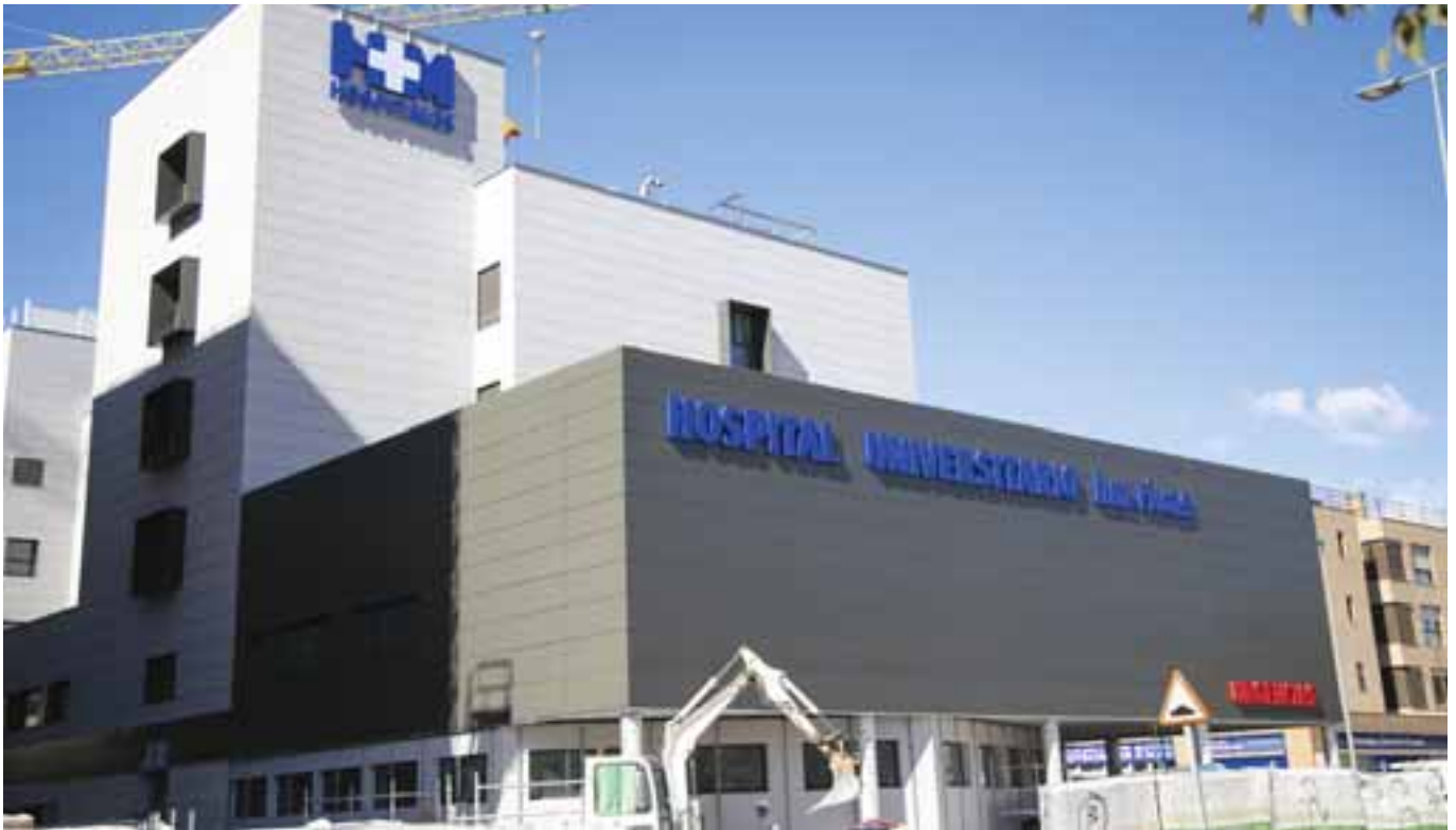
El nuevo hospital se ubica al lado del metro Rivas Futura. Imagen tomada a finales de septiembre, con las obras próximas a concluir. PACO MARISCAL
