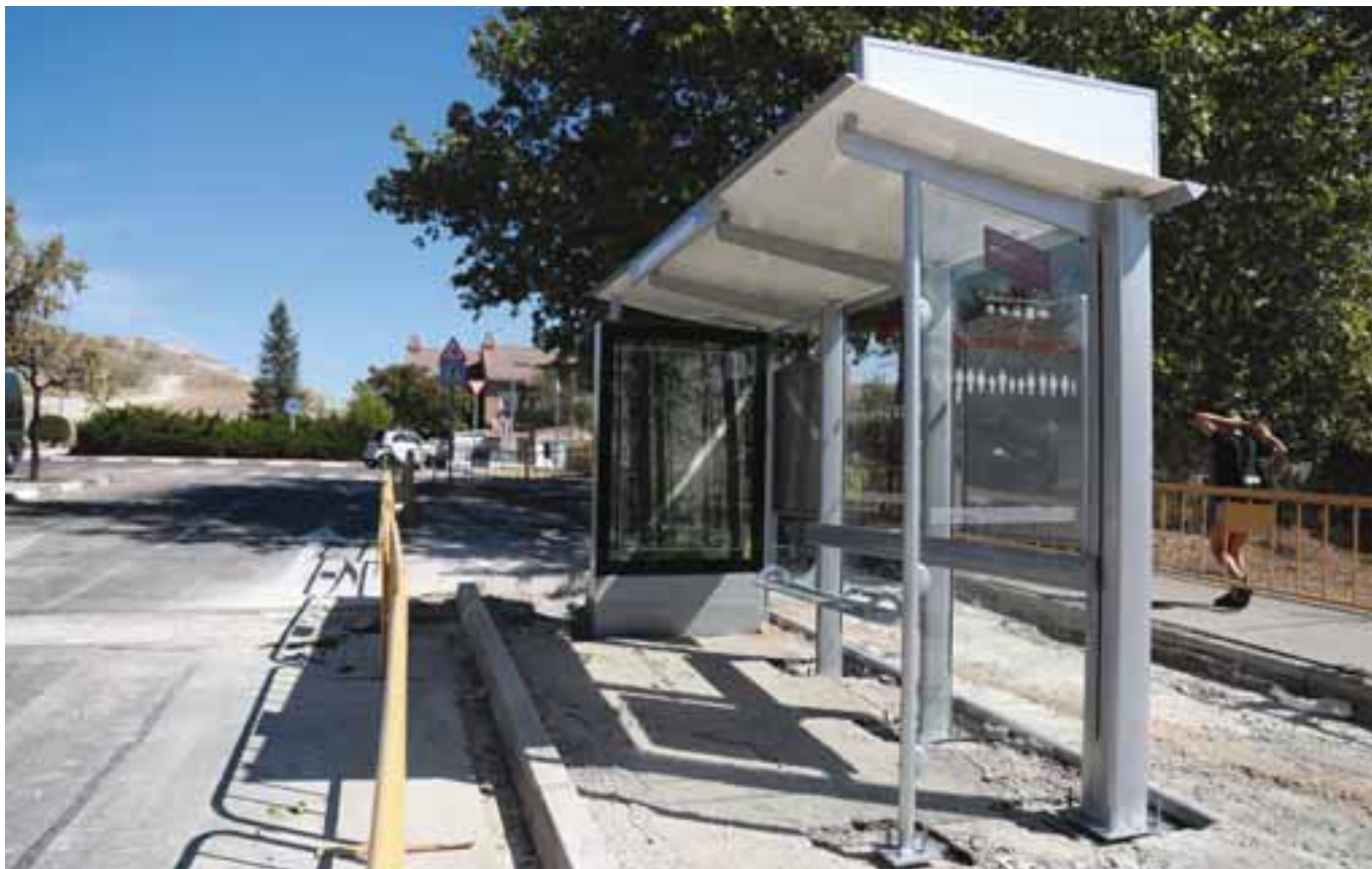
Obras en una de las aceras, a finales del pasado mes, dentro del plan de ampliación y mejora de la accesibilidad.
