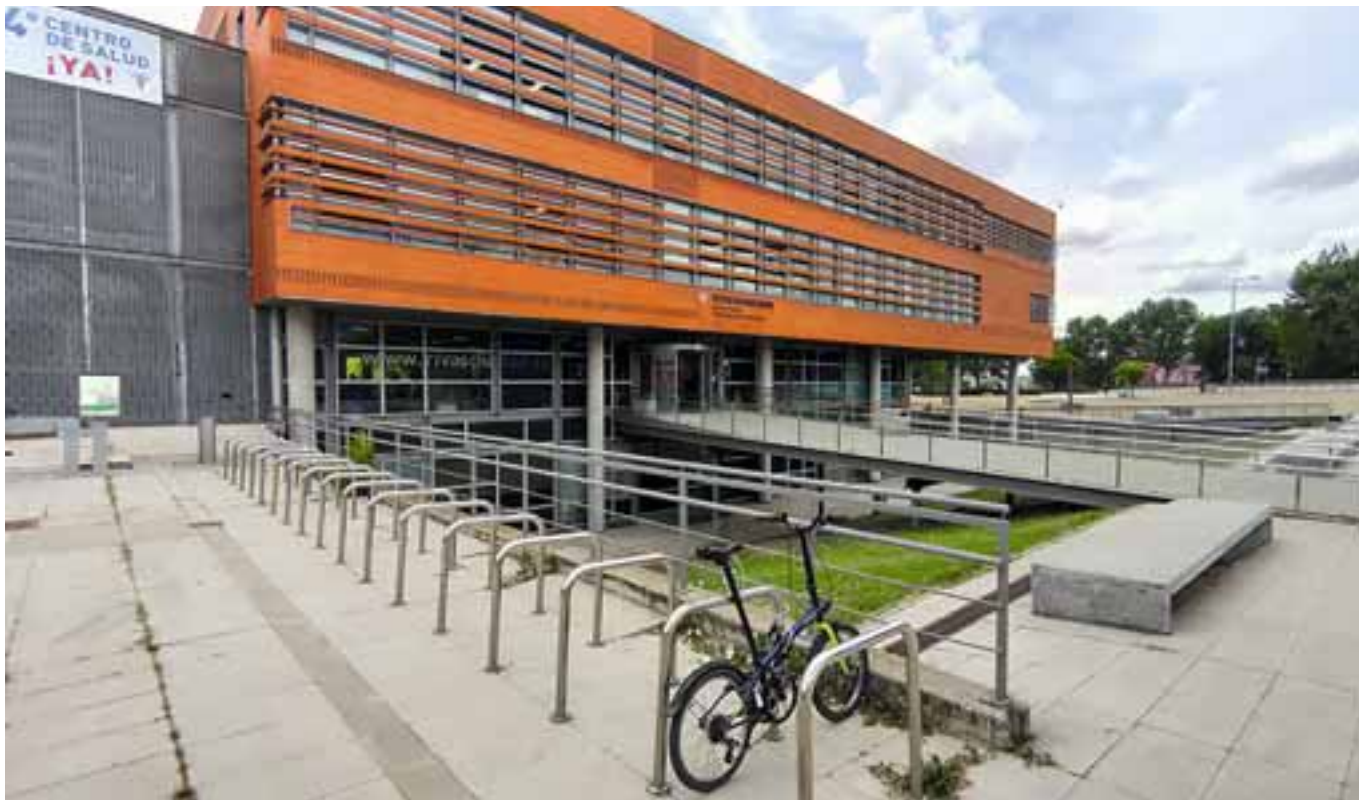
Un aparcamiento municipal para bicicletas, frente al Ayuntamiento, en la plaza de la Constitución. N.A.A.
