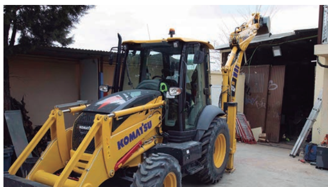
Una excavadora municipal derriba una de las construcciones ilegales.
