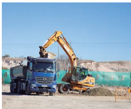
Maquinaria pesada en las obras. P. MARISCAL
