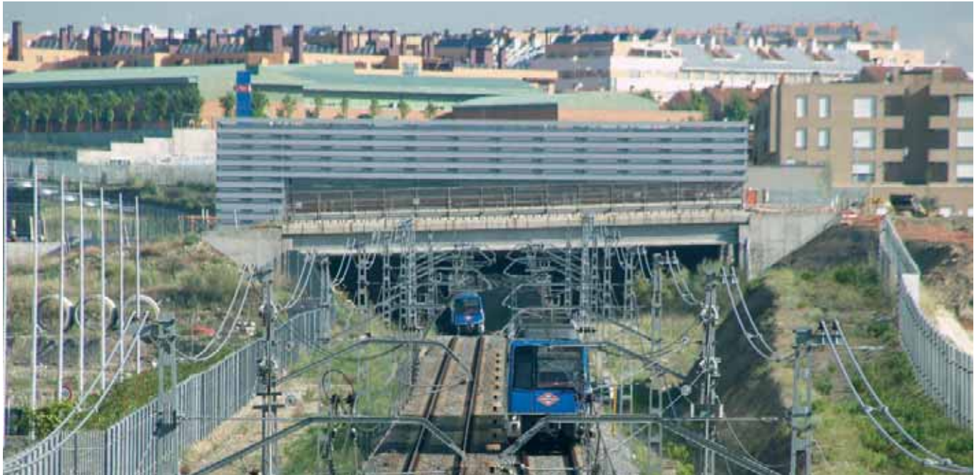
La nueva estación de metro Rivas Futura, al fondo, con dos convoyes pasando bajo sus andenes, aún en construcción, el pasado 24 de junio.
