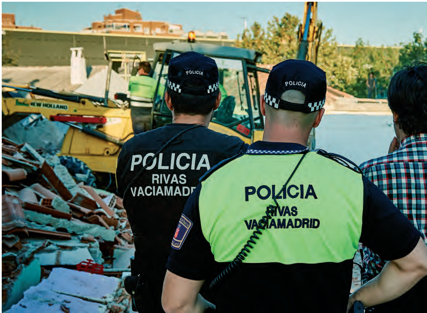
Agentes de la Policía Local, durante el derribo de las tres edificaciones derribadas donde se traficaba con droga. LUIS GARCÍA CRAUS.
